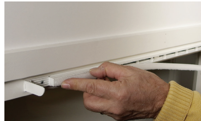
Elekrostaattisen allergeenisuodattimen vaihto
