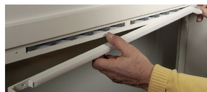
Ilmakierron ohjausyksikkö ja solumuovisuodatin
